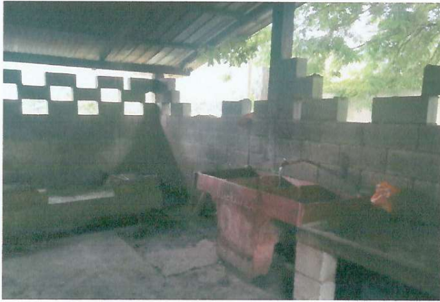
REMODELACIÓN DE COCINA
