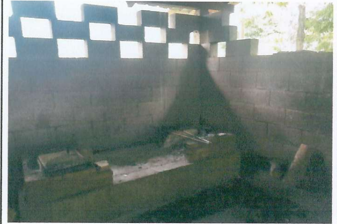
REMODELACIÓN DE COCINA
