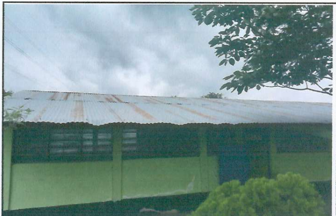
PINTURA DE MURO INTERIOR Y EXTERIOR
